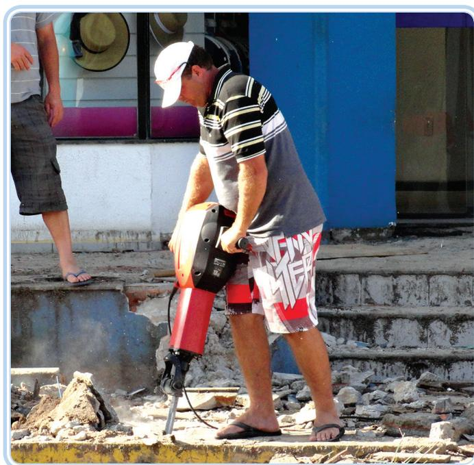
**Figura 9.6:** Trabalhador operando um martetele sem EPI's
