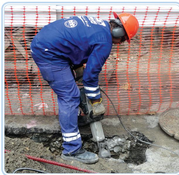
**Figura 9.5: Trabalhador operando um martetele com EPI's**
